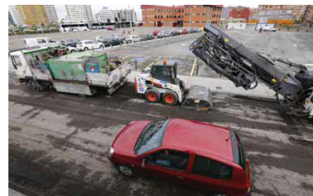
Obras en la calzada de la calle Carlos Marx. :: JORGE PETEIRO
